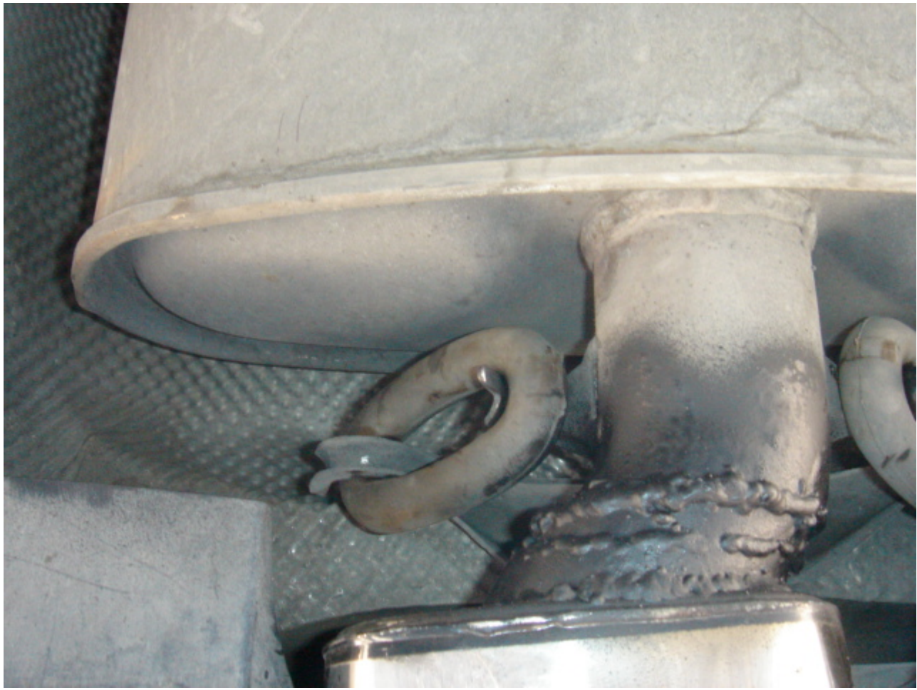
Otra imagen más de las soldaduras :
